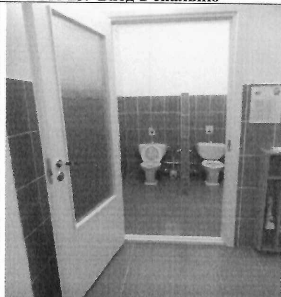
Фото 25. Вход в туалетные кабинки
