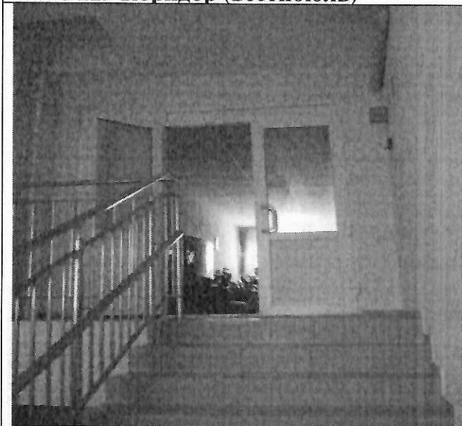
Фото 13 Лестница внутри здания
